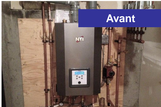
Chaudière au propane avec chauffe-eau sans réservoir intégré
