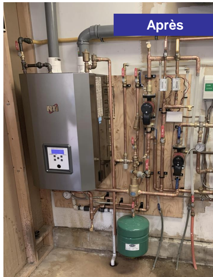
Chaudière au propane avec chauffe-eau sans réservoir intégré
