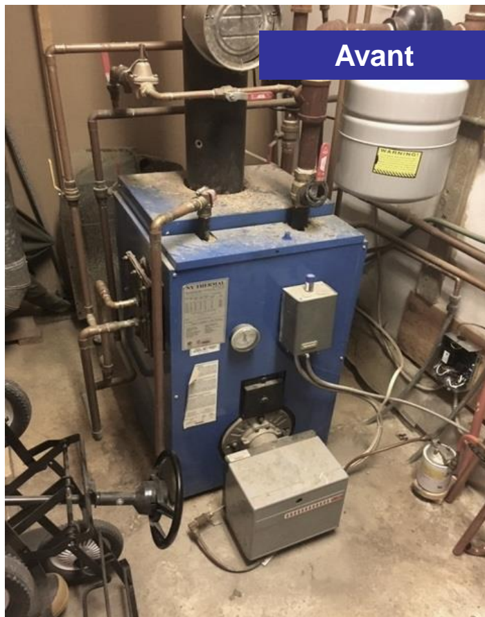
Chaudière au mazout avec serpentin
