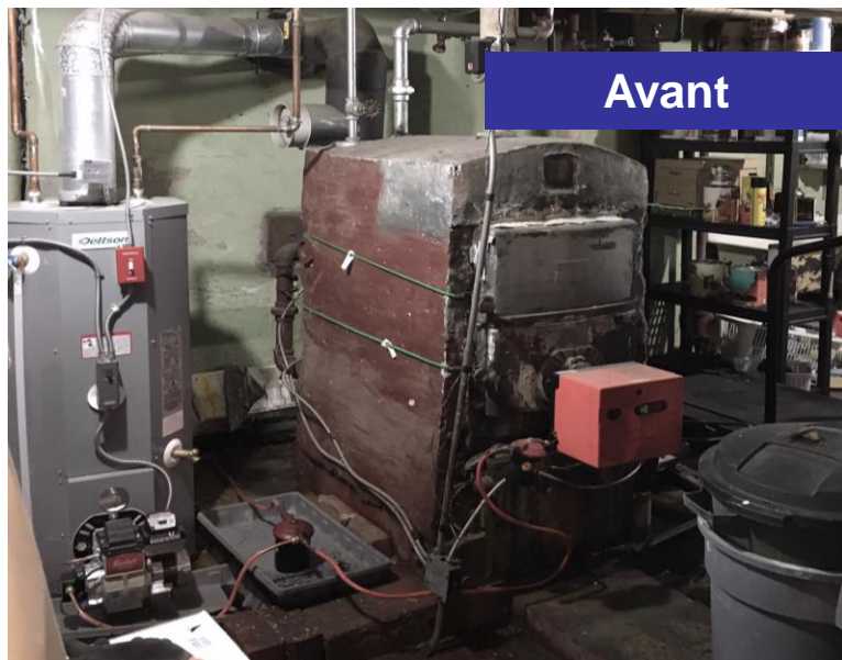
Chaudière au mazout avec chauffe-eau au mazout
