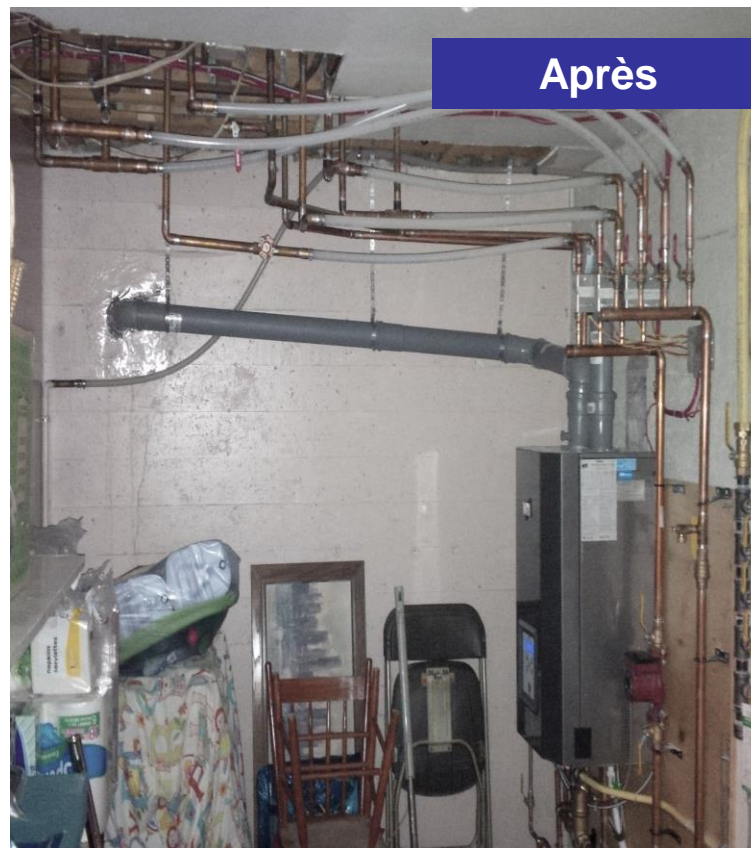
Chaudière au propane avec chauffe-eau sans réservoir intégré
