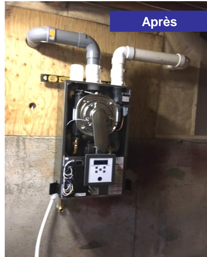
Chaudière au propane avec chauffe-eau sans réservoir intégré
